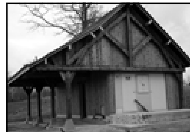
Construction d'un chalet cache-transformateur dans le parc naturel régional du Gâtinais (Saint-Sauveur sur Ecole)
