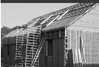
Bâtiment pour la ville de Valmondois (95)
