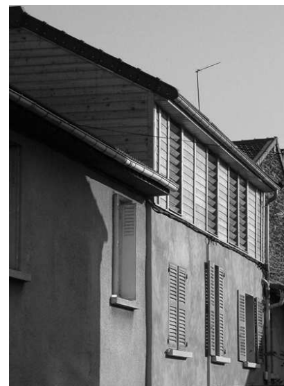
Surélévation en ossature bois (93)
